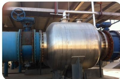
■ 1000 Nm<sup>3</sup>/min 发酵尾气除水除杂
